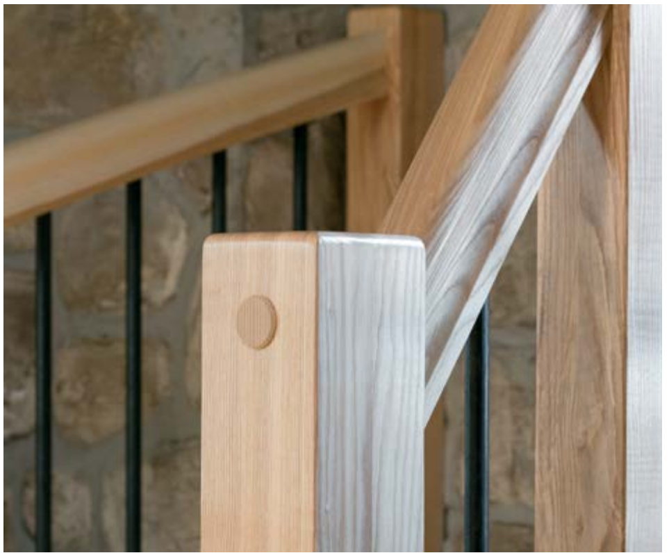
Wangentreppe COMFORTLINE aus Esche MB gefertigt, Stäbe aus Schwarzstahl, Handlauf als Omegahandlauf in geschwungener Ausführung, Oberfläche lackiert.
