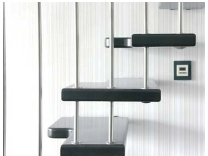
Treppe aus Buche MB gefertigt mit einer dunkel geölten Oberfläche, Stäben und Distanzen aus Edelstahl. RS014
