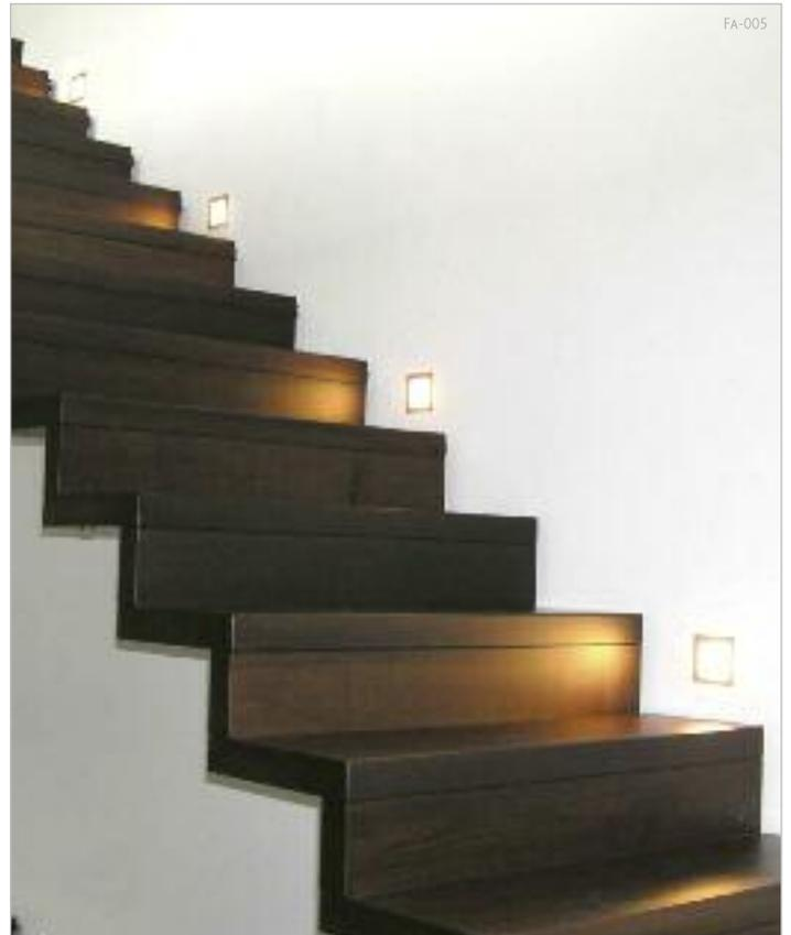
*Treppe FALTWERK aus Buche durchgehende Lamelle blockverleimt gefertigt. Oberfläche gebeizt und lackiert.*
