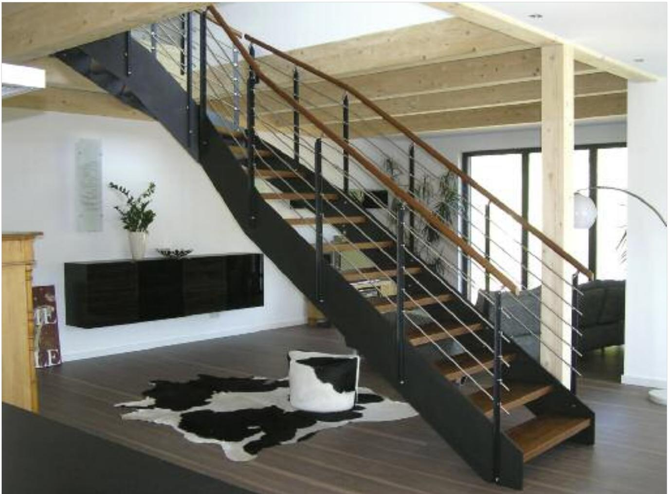
Stufen und Rundhandläufe aus blockverleimter Buche mit aufwendig gebeizter und lackierter Oberfläche. Ein besonderer Blickfang ist das Edelstahlringgeländer mit T-Pfosten.
