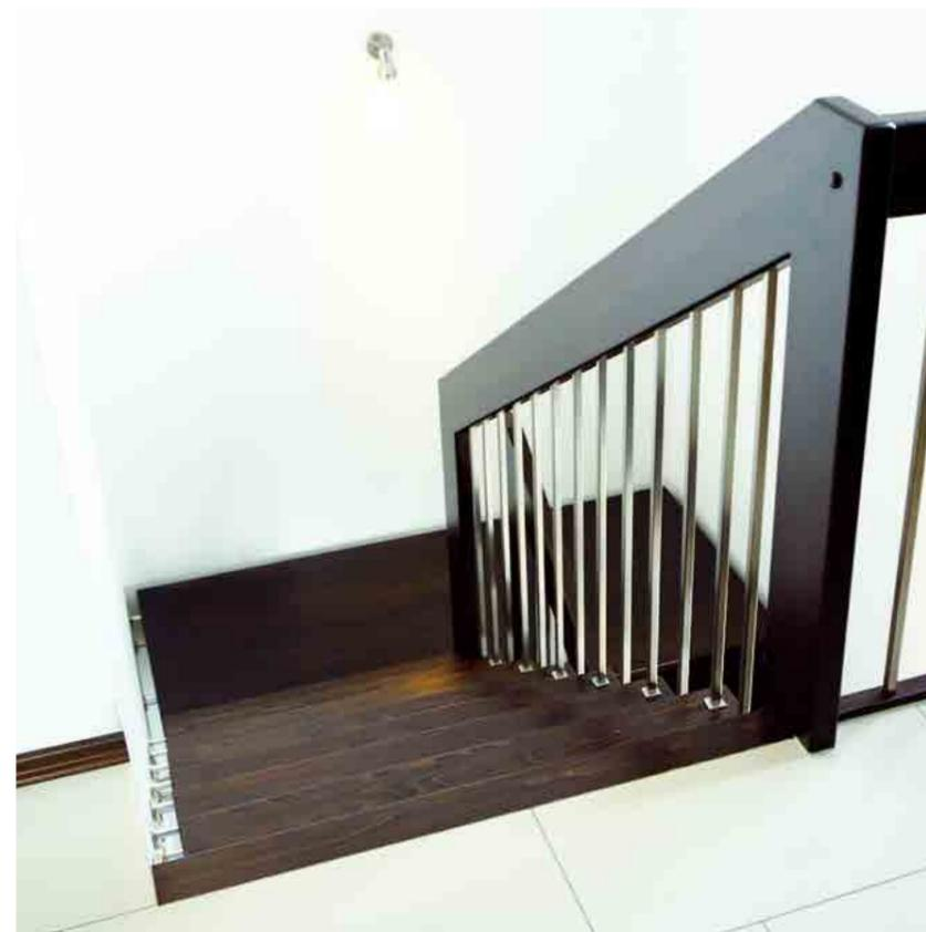
Markantes Detail: die rechteckigen Austrittsposten in 45 x 160 mm mit seitlich angeschlossenem Brüstungsgeländer.
