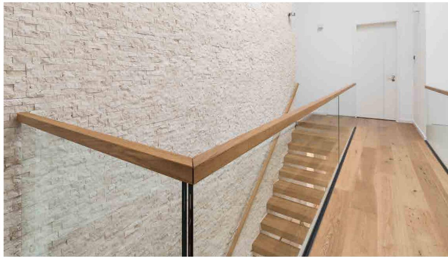
Kragwerk Treppe in Eiche MB gefertigt, Oberfläche geölt, Brüstungsgeländer als eingespannte Verglasung.
