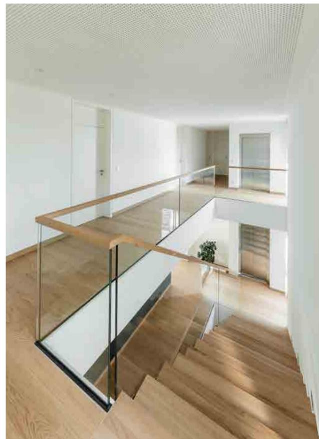
Kragwerk Treppe aus Eiche MB mit geölter Oberfläche, seitliche Verglasung über Punkthalter aus Edelstahl, Brüstungsgeländer als eingespannte Verglasung mit Bodenleiste, Handlaufleiste Eiche MB geölt.
