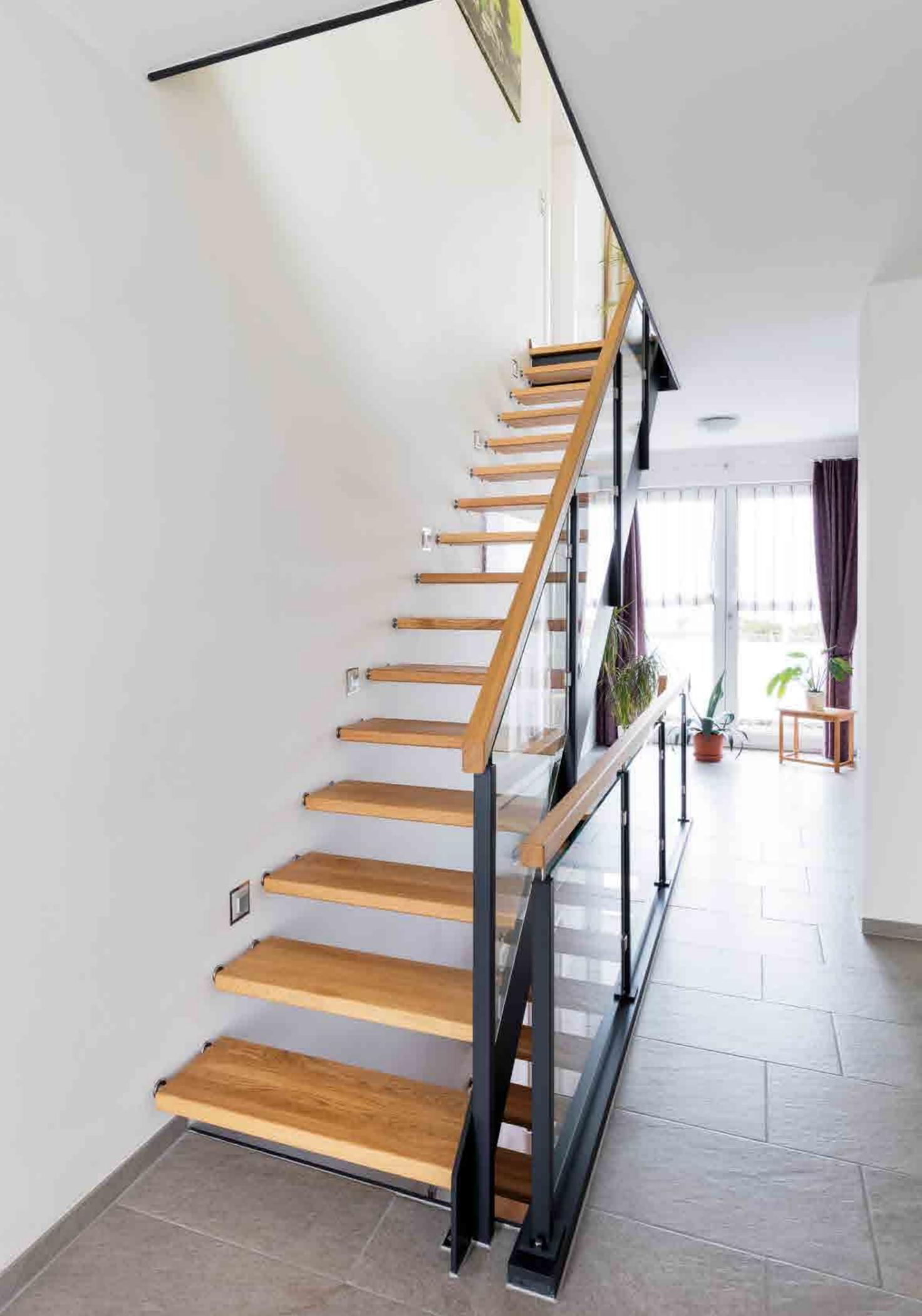
Steelline Treppe als wandgebolzte schalldämmende Ausführung, Stufen aus Holzart Eiche MB gefertigt, Oberfläche umweltfreundlich geölt, Pfosten als Quadratpfosten, Geländerfüllung aus Sicherheitsglas.
