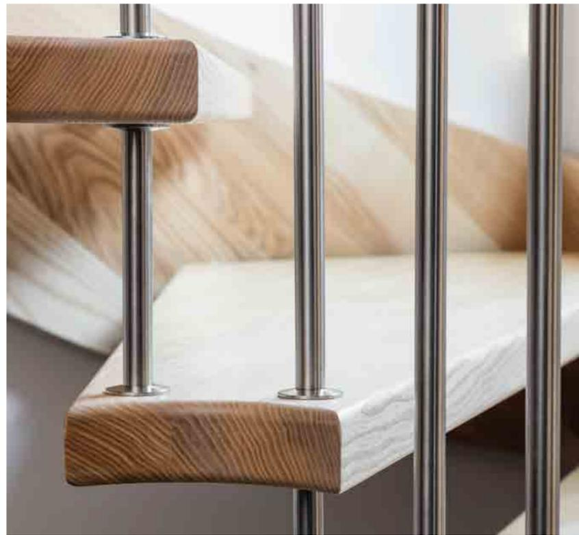
StandardLine in Holzart Esche MB, Stäbe und Tragbolzen aus Edelstahl gefertigt, die Stufen wurden wandseitig schalldämmend in die Wange gebolzt. Ausführung des Handlaufes als Handlaufkrümmling, Oberfläche umweltfreundlich geölt.
