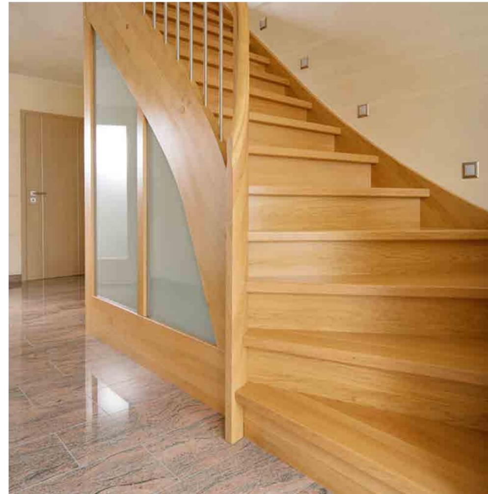
ComfortLine in Kernesche, durchgehende Lamelle blockverleimt. Oberfläche 3-fach lackiert. Ausgestattet mit Wangen und Handlaufkrümmung. Stäbe aus Edelstahl gefertigt. Verkleidung des Kellerabgangs als Holz-/Glaselement mit satinierten Glasscheiben.
