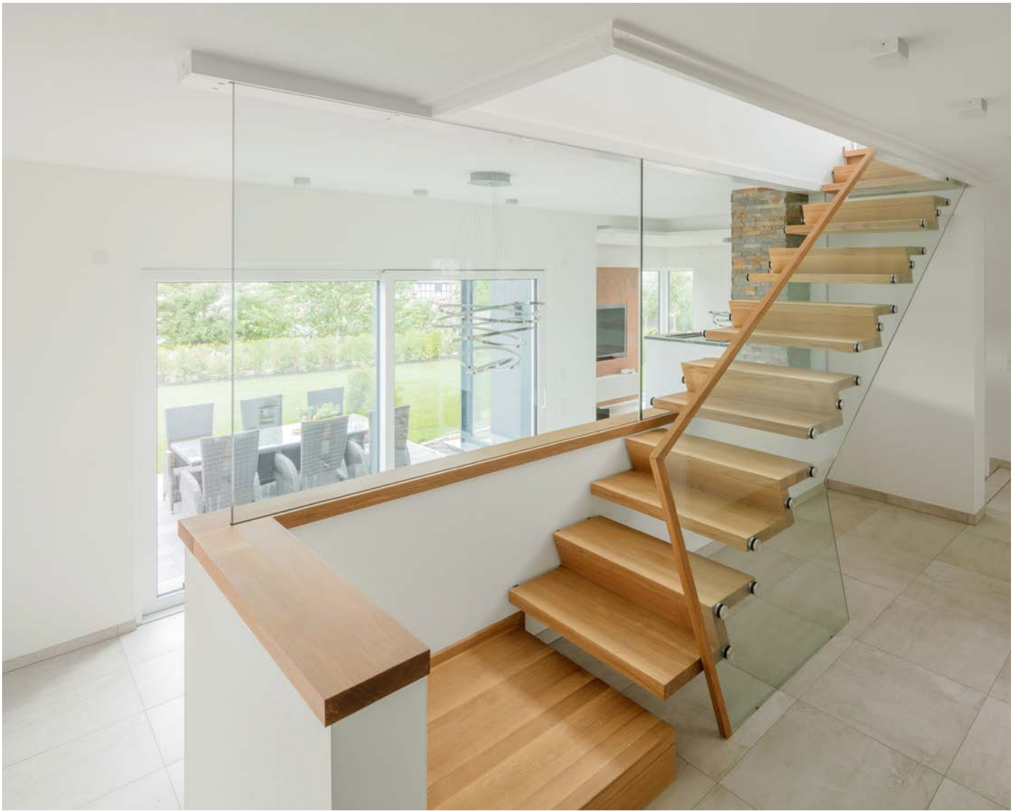
Krafa Treppe in Eiche gefertigt, Oberfläche geölt, Brüstungsgeländer als eingespannte Verglasung.
