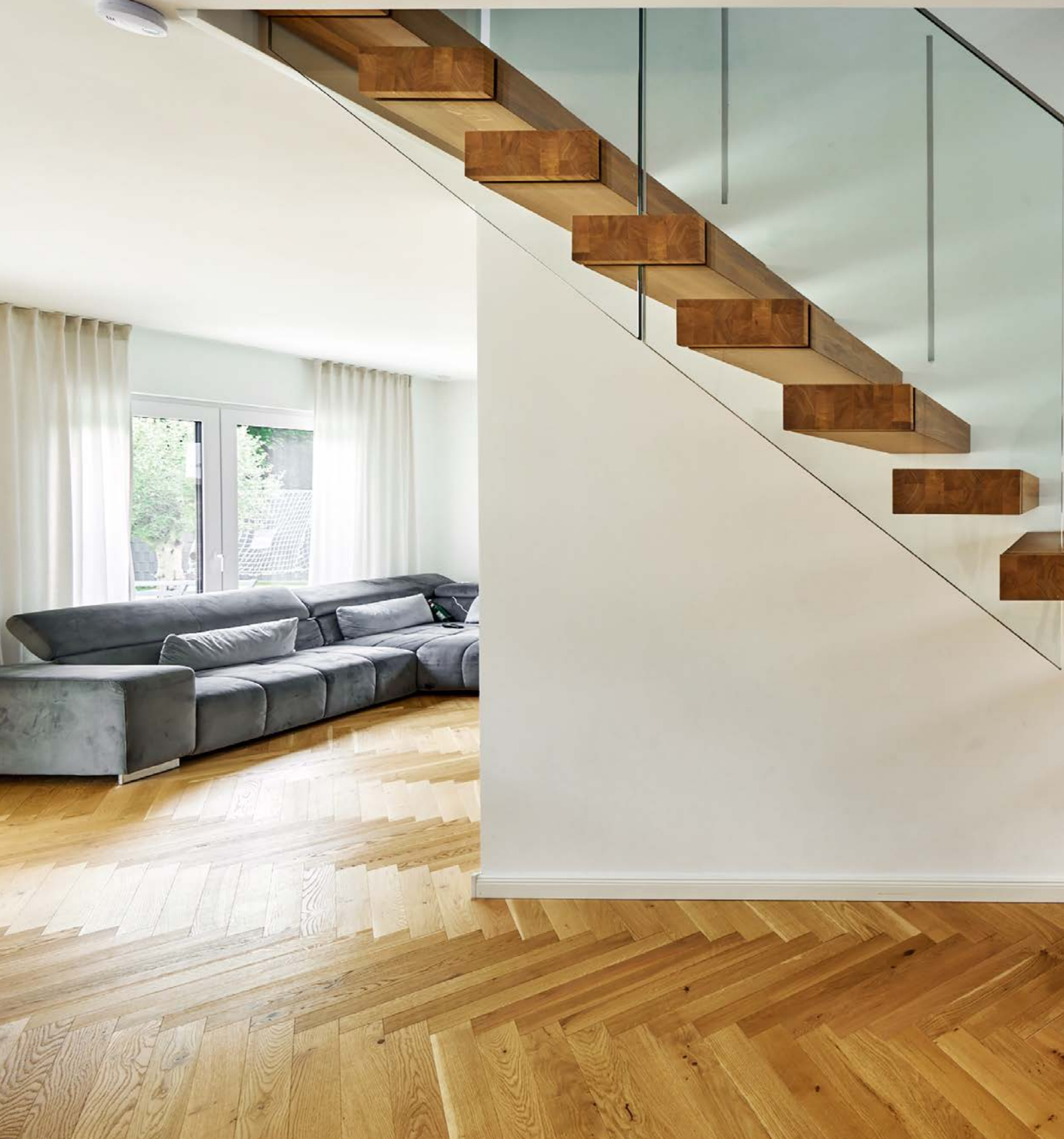
Treppe Kragarm aus Eiche geölt. Mit Ganzglasgeländer und Applikationen auf den Glaspunkthaltern.
