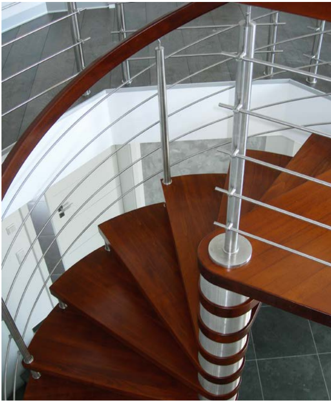
CreativeLine aus Buche mit durchgehender Lamelle blockverleimt gefertigt. Edelstahlreilingeländer „Rondo“. Oberfläche gebeizt und lackiert. Formverleimter Handlauf als markantes Designelement.
