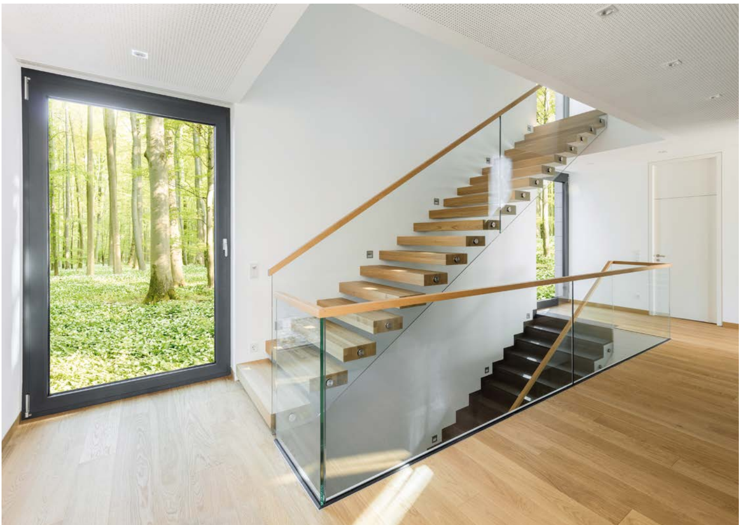
Kragwerk Treppe aus Eiche Massivholz blockverleimt mit geölter Oberfläche, seitliche Verglasung über Punkthalter aus Edelstahl, Brüstungsgeländer als eingespannte Verglasung mit Bodenleiste, Handlaufleiste Eiche Massivholz blockverleimt, geölt.
