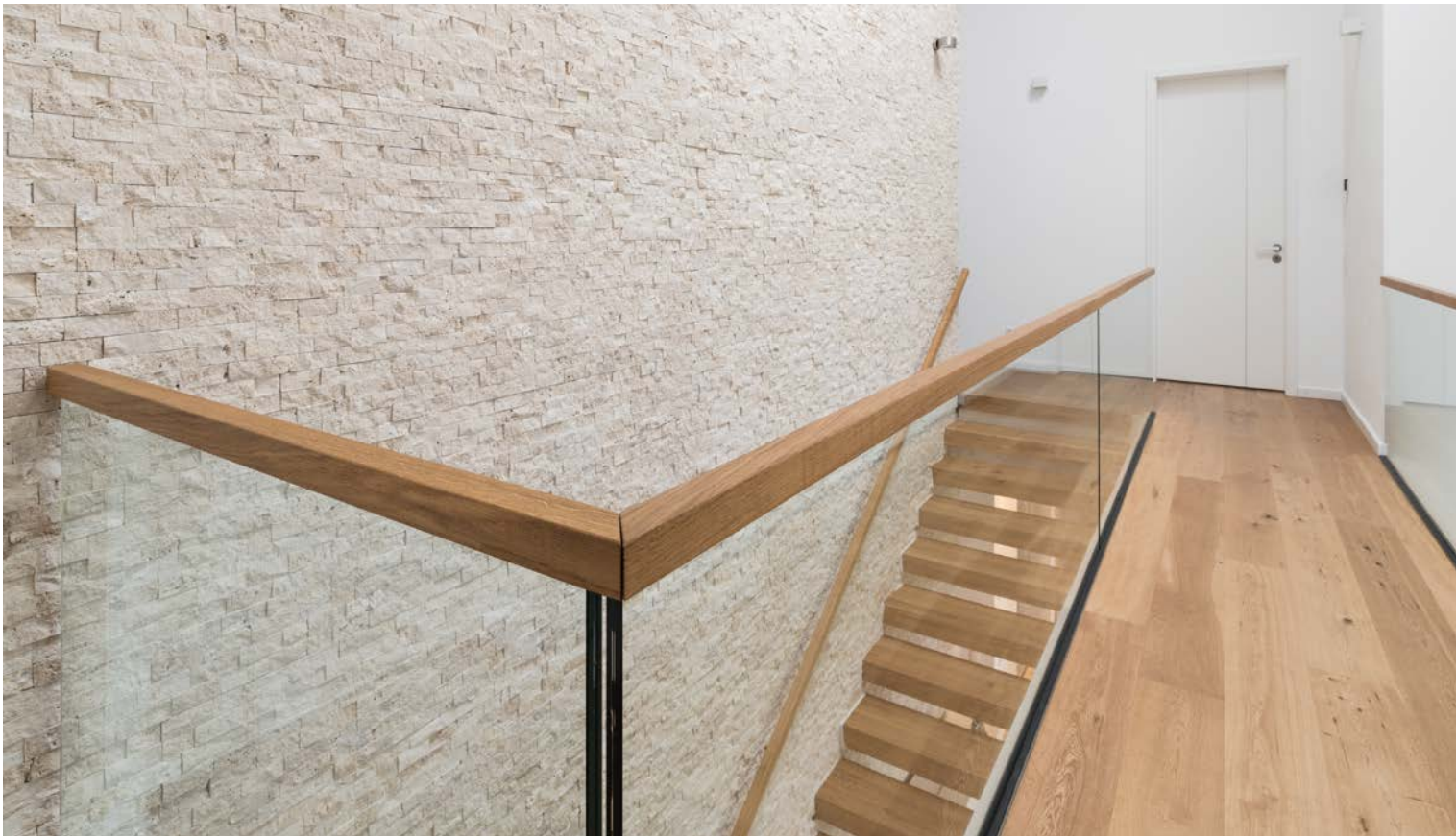
Kragwerk Treppe in Eiche Massivholz blockverleimt gefertigt, Oberfläche geölt, Brüs- tungsgeländer als eingespannte Verglasung.
