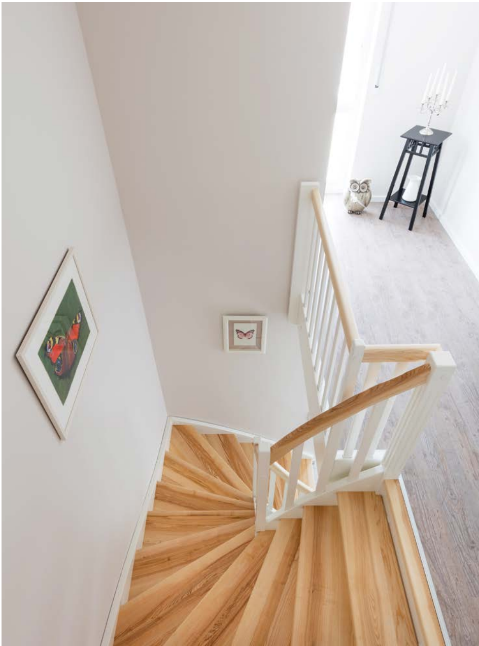
Wangentreppe ComfortLine im edlen Landhausstil, Stufen Esche Massivholz blockverleimt, geölt, Wangen und Pfosten weiß lackiert, Stäbe als Brettsprossen und in weißer Lackierung.
