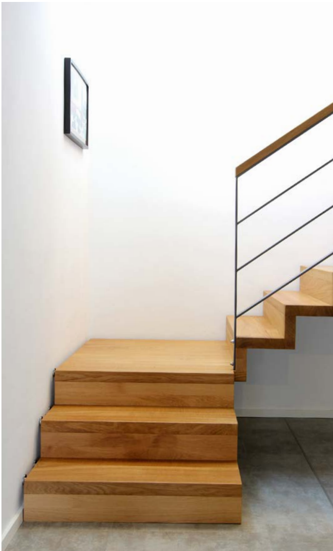
Faltwerk in Eiche, durchgehende Lamelle blockverleimt. Oberfläche geölt. Geländer als Flachstahlgeländer mit Griffleiste aus Eiche.
