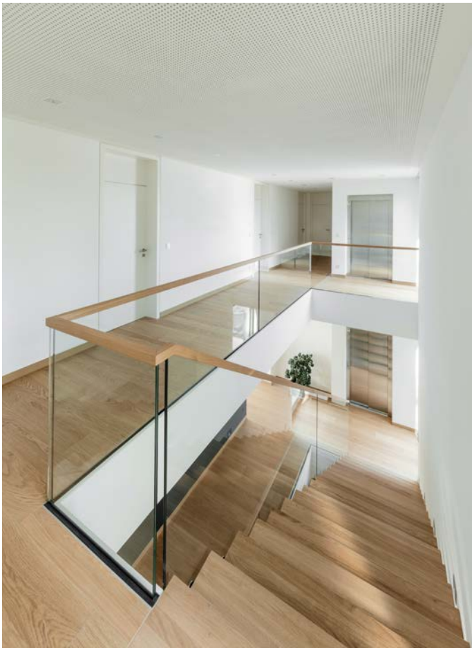
Kragwerk Treppe aus Eiche Massivholz blockverleimt mit geölter Oberfläche, seitliche Verglasung über Punkthalter aus Edelstahl, Brüstungsgeländer als eingespannte Verglasung mit Bodenleiste, Handlaufleiste Eiche Massivholz blockverleimt, geölt.
