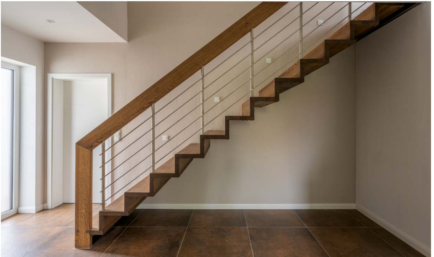
Treppe aus Buche gefertigt mit einer gebeizten Oberfläche und Stäben aus Edelstahl.
