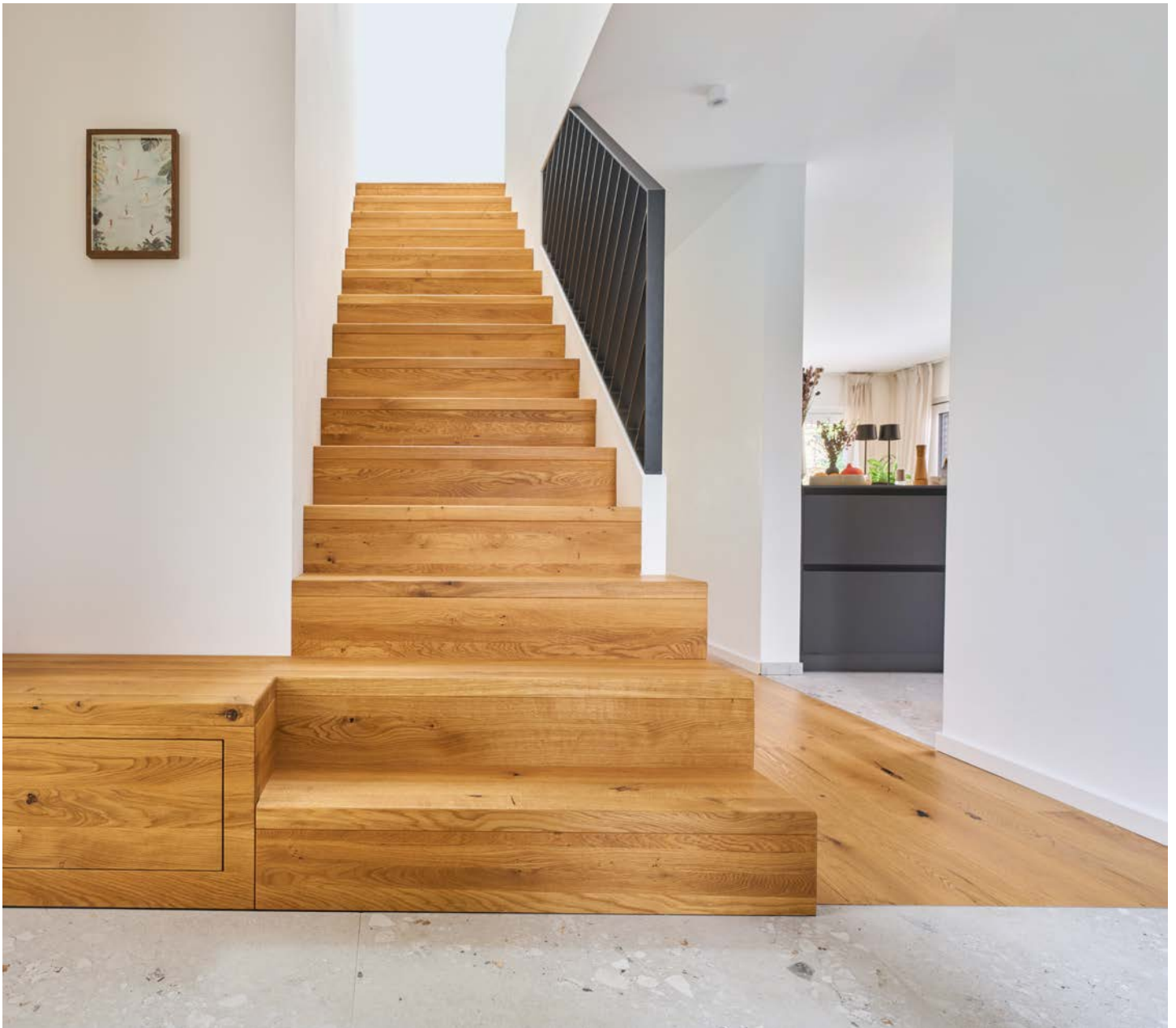
Aufgesattelte Faltwerktreppe aus Wildeiche gefertigt mit geölter Oberfläche sowie Flachstahlgeländer.
