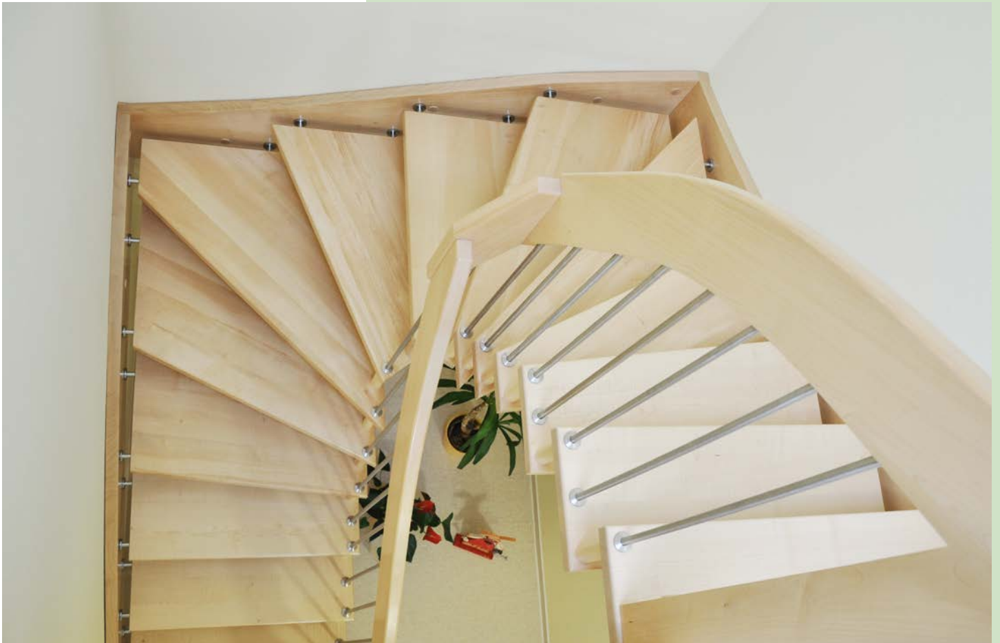
StandardLine in Holzart Buche, durchgehende Lamelle blockverleimt. Stäbe in Edelstahl und Tragbolzen aus Buche gefertigt. Ausführung der Handläufe in geschwungener Form. Wandwange in gebolzter Ausführung.
