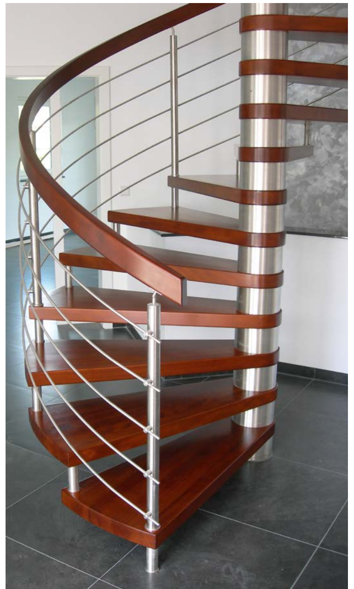
CreativeLine aus Buche mit durchgehender Lamelle blockverleimt gefertigt. Edelstahlreilingeländer „Rondo“. Oberfläche gebeizt und lackiert. Formverleimter Handlauf als markantes Designelement.
