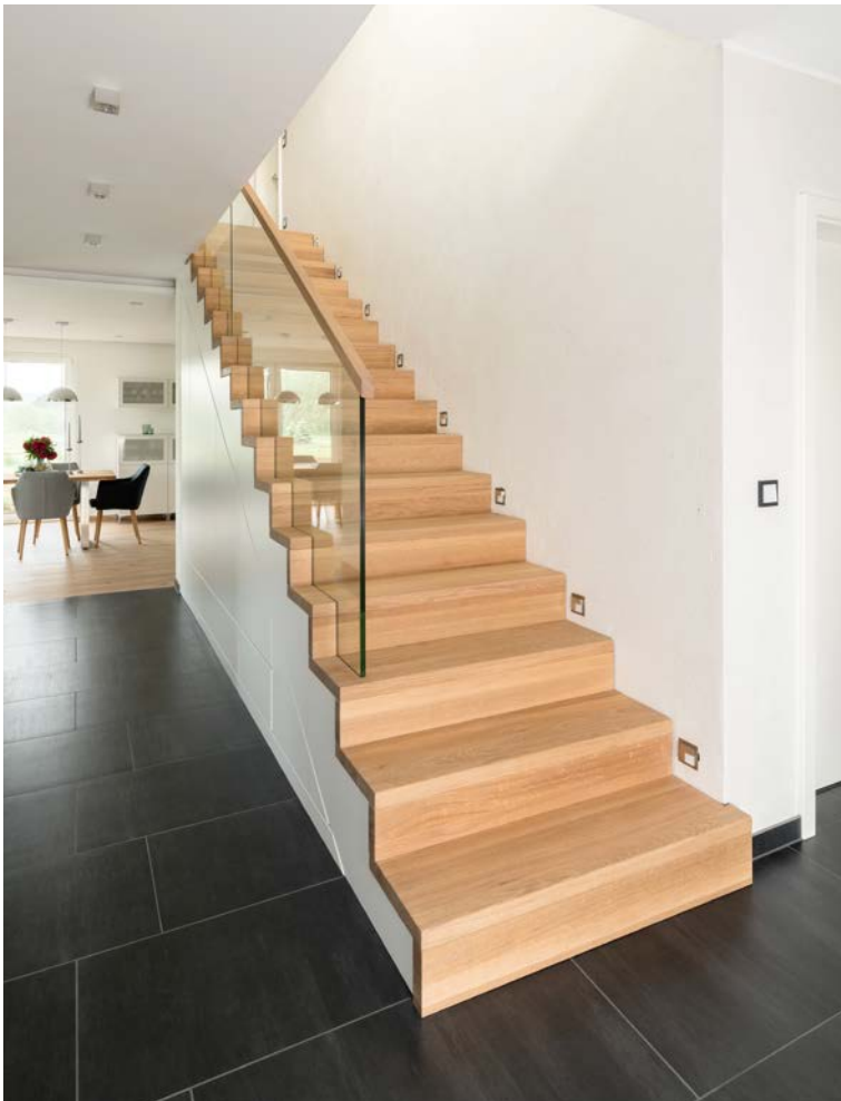
Aufgesattelte Faltwerk Treppe aus Eiche gefertigt mit Glasgeländer und Schranklösung unter der Treppe. Oberfläche geölt.
