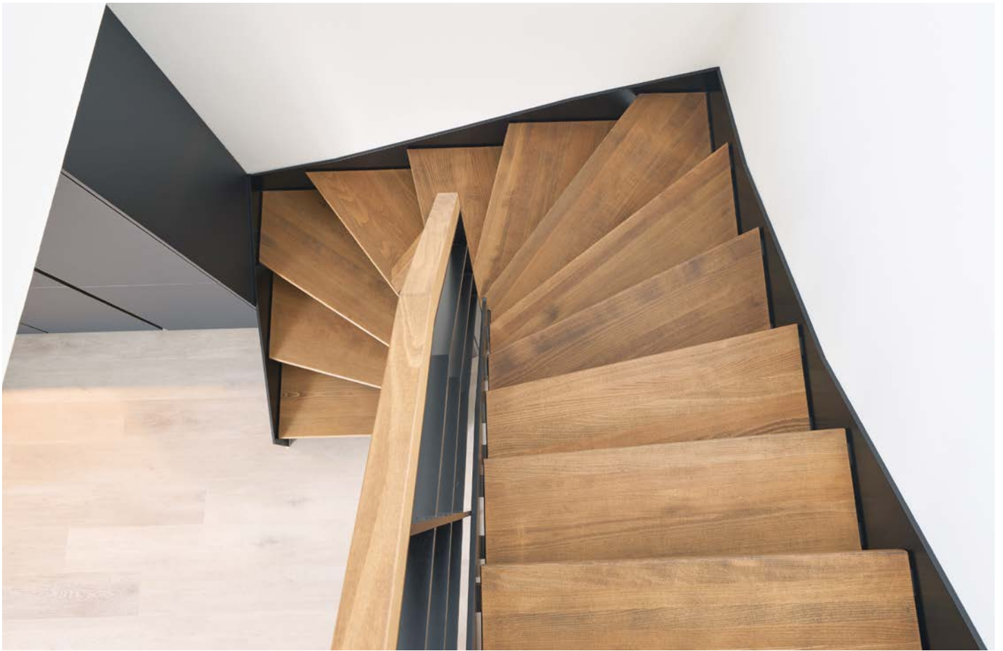
Treppe SteelLine mit Stufen aus Buche mit durchgehender Lamelle und einer Dekoröl Oberfläche
