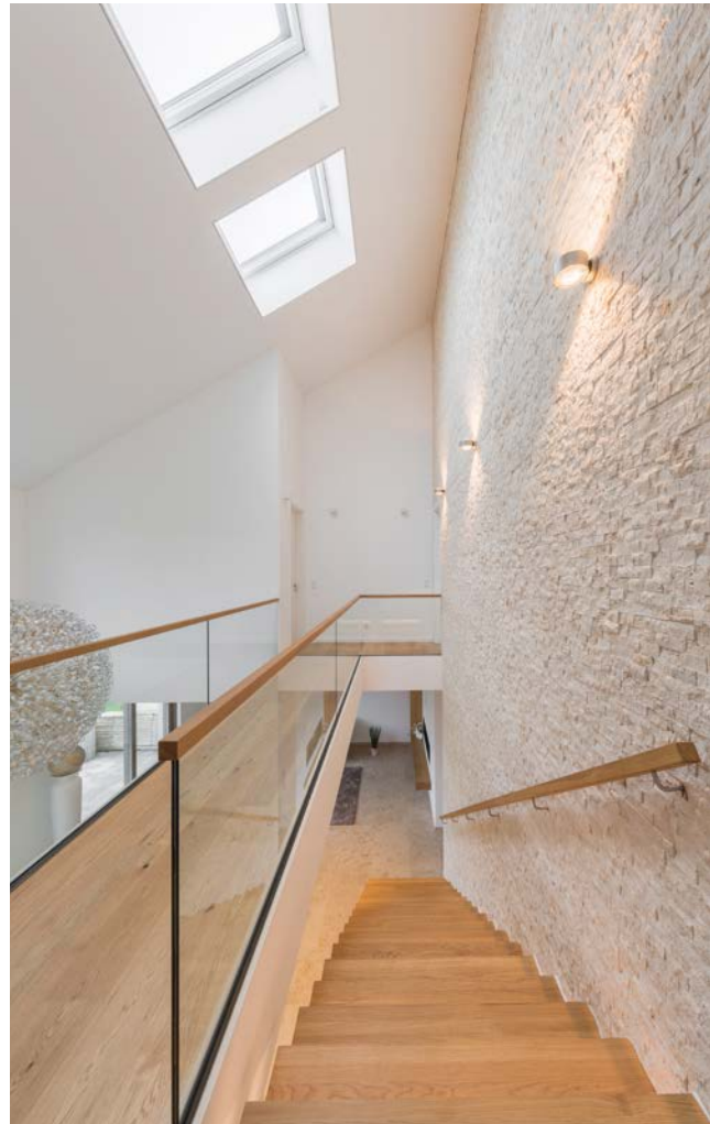
Kragwerk Treppe in Eiche Massivholz blockverleimt gefertigt, Oberfläche geölt, Brüs- tungsgeländer als eingespannte Verglasung.
