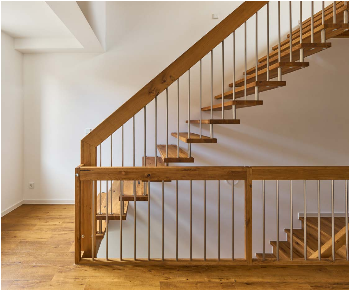
Basicline in Holzart Wild- eiche mit durch- gehender Lamelle. Oberfläche geölt mit Stäben und Tragbolzen aus Edelstahl gefertigt.
