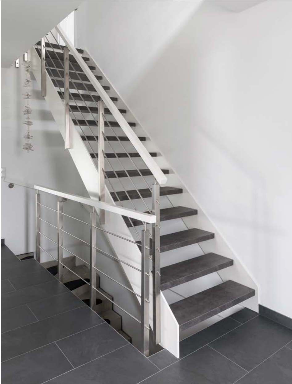
SteelLine Treppe als gerade Treppenanlage mit Quadratpfosten aus Edelstahl sowie Relingurten aus Edelstahl. Stufen aus Robust Plus Schiefer.
