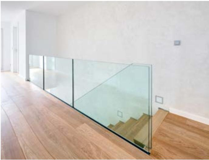
*Hier in einer geölten Eiche-Ausführung. Das steigende Geländer besteht aus Sicherheitsglas. Brüstungsgeländer als eingespannte Verglasung mit Bodenprofil. KR001*
