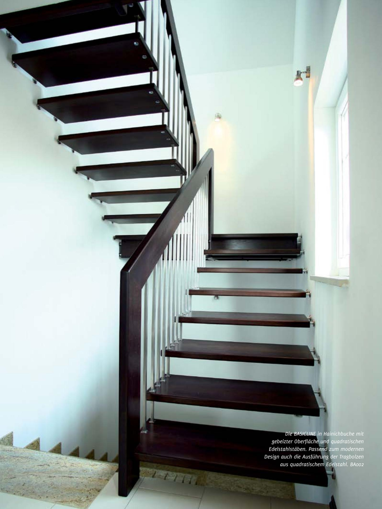
*Die BASICLINE in Hainichbuche mit gebeizter Oberfläche und quadratischen Edelstahlstäben. Passend zum modernen Design auch die Ausführung der Tragbolzen aus quadratischem Edelstahl. BA002*
