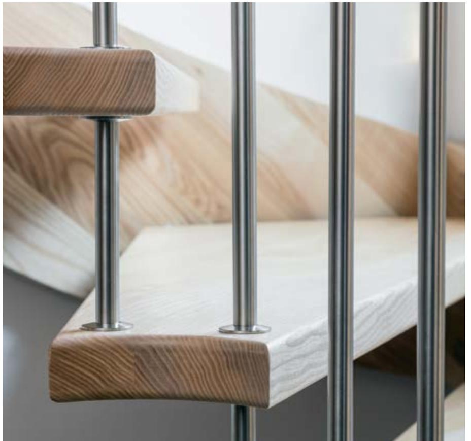
*STANDARDLINE in Holzart Esche MB, Stäbe und Tragbolzen aus Edelstahl gefertigt, die Stufen wurden wandseitig schalldämmend in die Wange gebolzt. Ausführung des Handlaufes als Handlaufkrümmling, Oberfläche umweltfreundlich geölt.*
