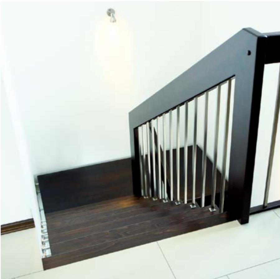
*Markantes Detail: die Austrittspfosten in 45 x 160 mm mit seitlich angeschlossenem Brüstungsgeländer. BA007*
